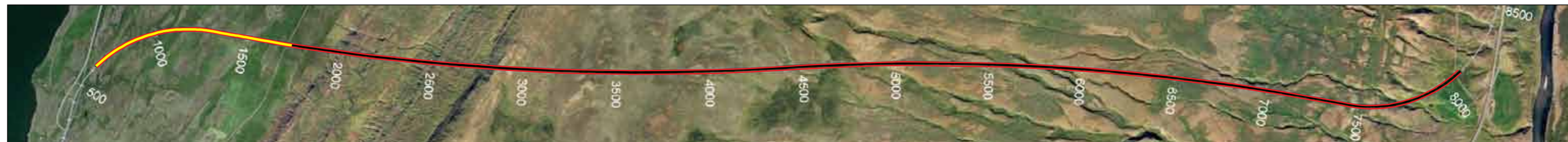
Vaðlaheiðargöng, staða framkvæmda 18. nóvember 2013. Búið er að sprengja 1.090 m frá Eyjafirði sem er 15,0% af heildarlengd.
